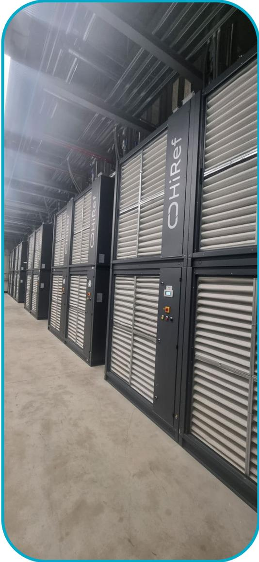
Gracias a un **análisis CFD detallado**, cada aspecto del diseño ha sido optimizado para **minimizar las pérdidas de carga** en el flujo de aire interno y reducir el consumo energético de los ventiladores. La amplia superficie del **intercambiador de aletas** garantiza una transmisión térmica eficaz, minimizando la diferencia térmica entre el aire de entrada y el agua de salida, maximizando la eficiencia global del sistema.
