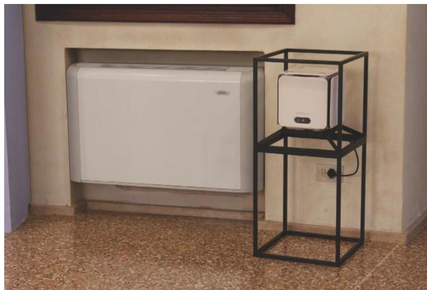
Gli spazi espositivi sono climatizzati tramite ventilconvettori Galletti prodotti su misura, modificando gli ingombri e aggiungendo un umidificatore a ultrasuoni e un dispositivo NTP (Galletti).
