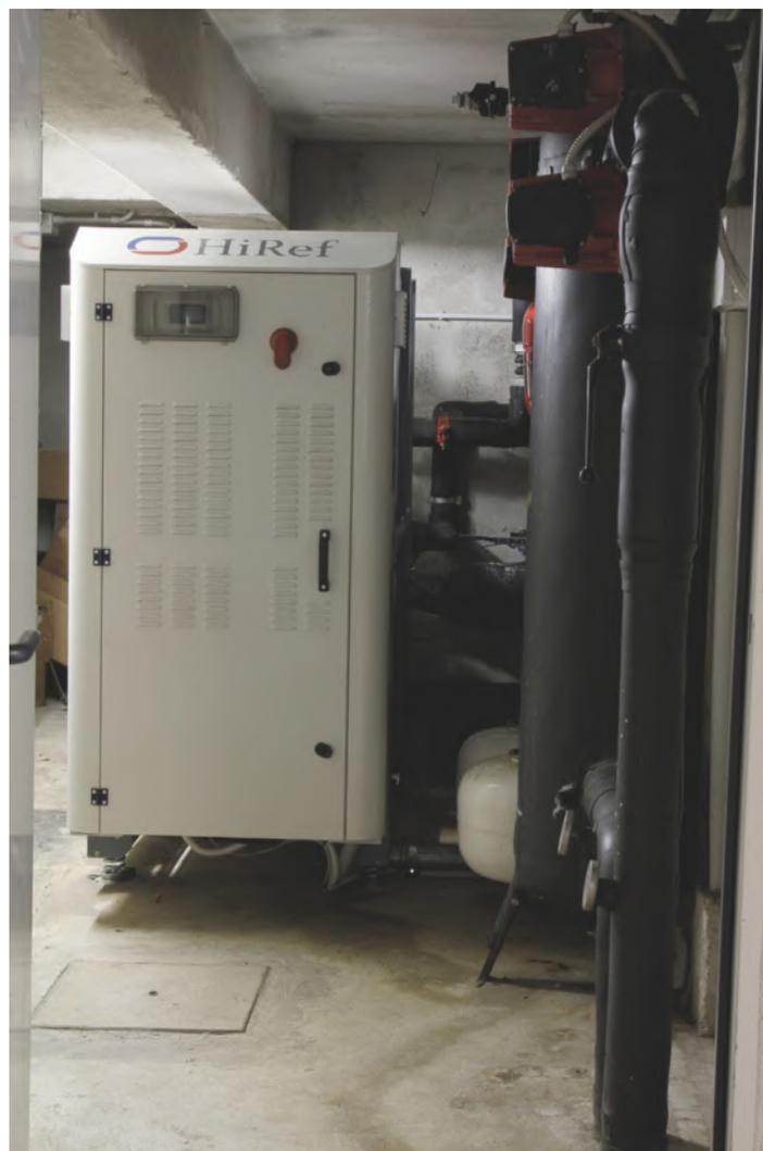
Il "cuore" del nuovo impianto di climatizzazione è la pompa di calore geotermica prodotta da HiRef ed equipaggiata con compressori scroll on/off e modulanti BLDC e valvole di laminazione elettroniche (HiRef).
