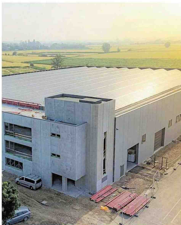
Il cantiere della nuova sede di Hiref
