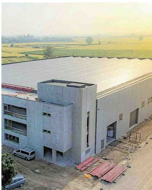
Il cantiere della nuova sede di Hiref
