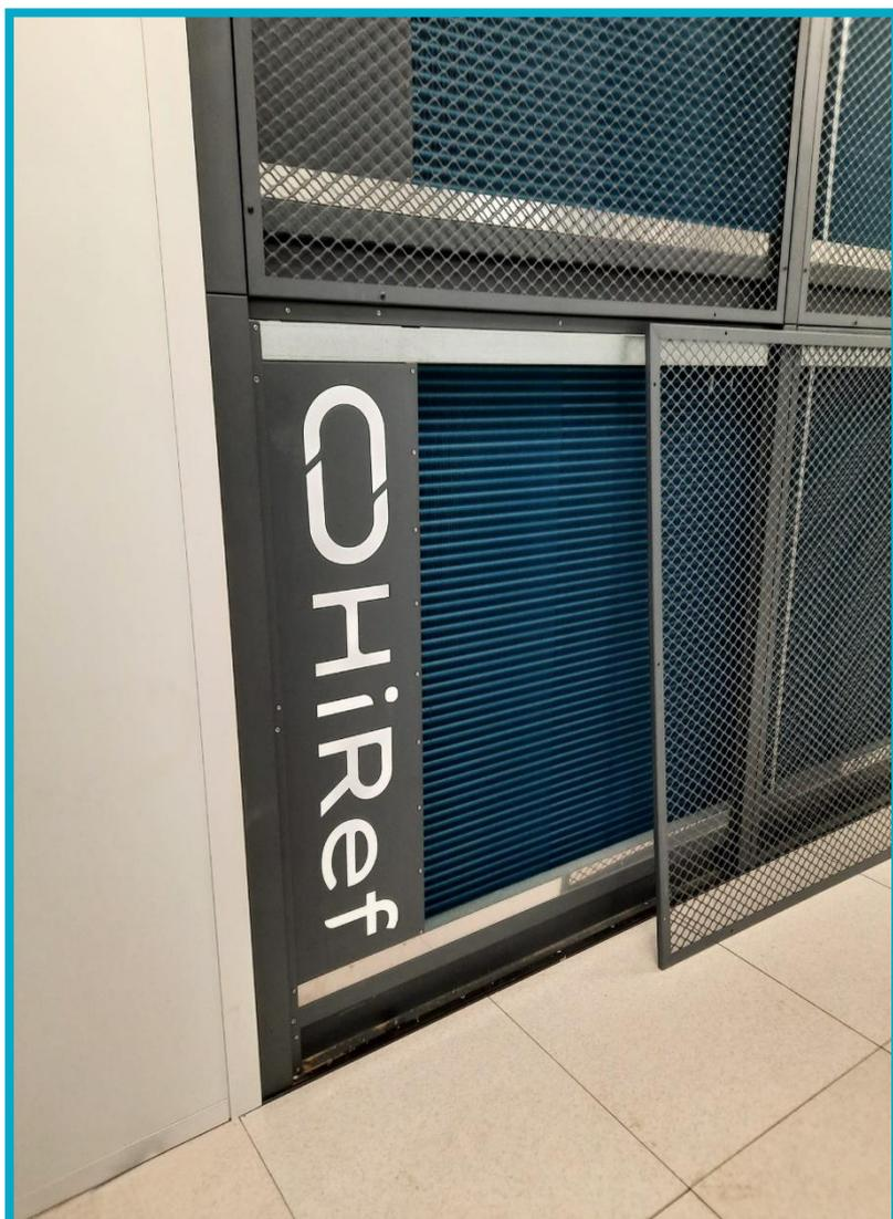
Otra ventaja del sistema radica en la facilidad de mantenimiento: las unidades **FanWall** están ubicadas fuera de la sala de servidores, en pasillos técnicos dedicados, e introducen el aire de impulsión en el ambiente a través de rejillas especiales integradas en la pared. Esta disposición permite intervenciones rápidas y seguras, sin necesidad de acceder directamente a la sala y sin comprometer sus condiciones climáticas internas.
