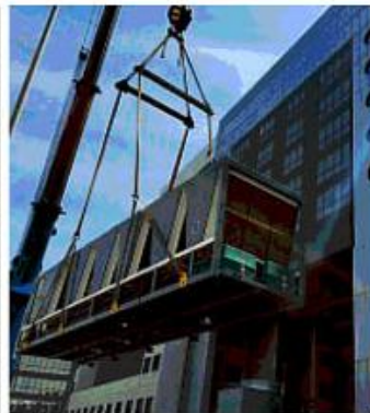
Espansione Uno degli impianti di raffreddamento per centri dati realizzati dall'azienda padovana HiRef, durante l'installazione
